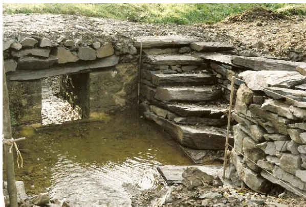
Œuvres en pierres sèches en bas du ruisseau Practical art in rocks at the base of the stream
